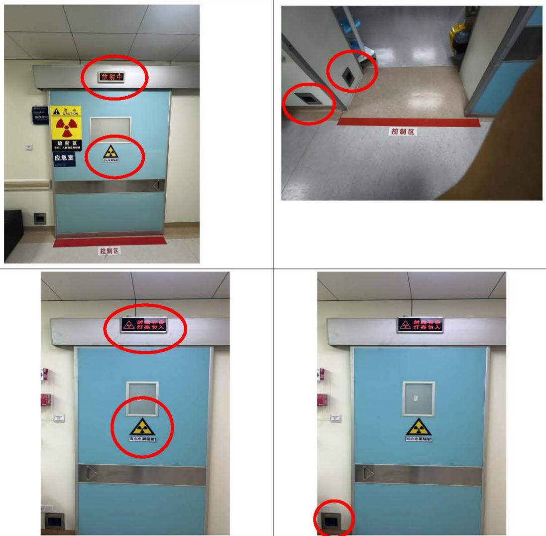
图 3-2 电离辐射警示标志及警示灯、出束指示灯、闭门装置
