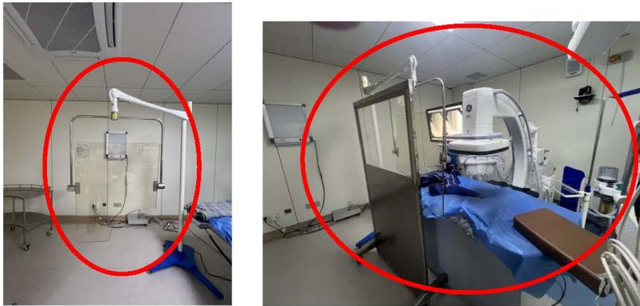
图 3-4 C 形臂 X 射线机自身防护设施
