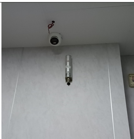
固定式 X-γ 报警探头（机房入口）
