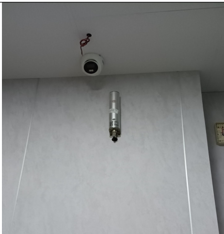
固定式 X- \gamma 报警探头（机房入口）
