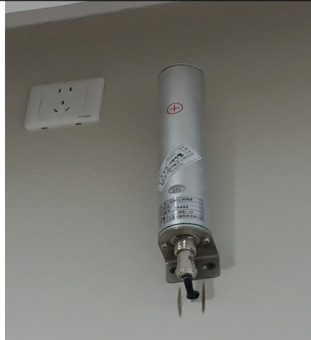
固定式 X- \gamma 报警探头（迷道处）
