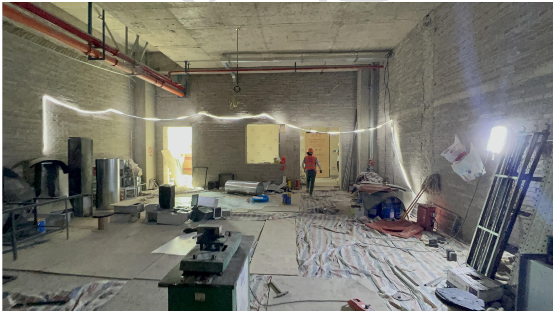
图 1-2 预留 DSA 机房现状照片
