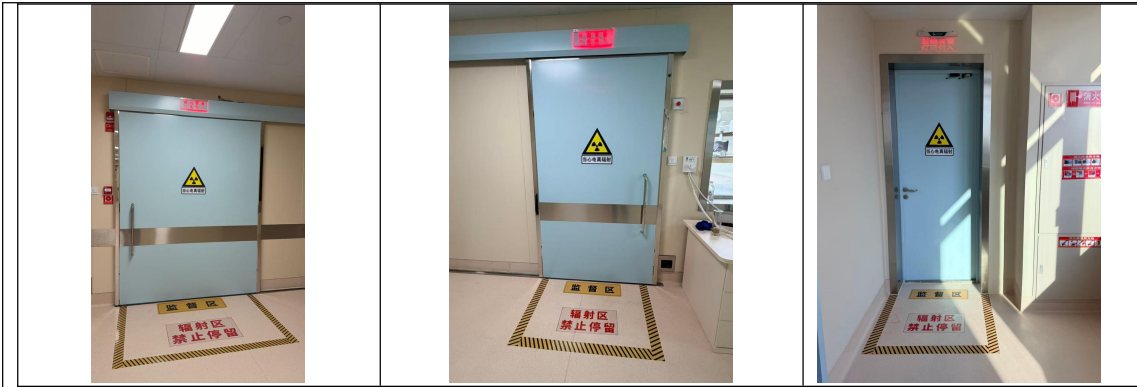
图 3-2 电离辐射警示标志及警示灯、出束指示灯
